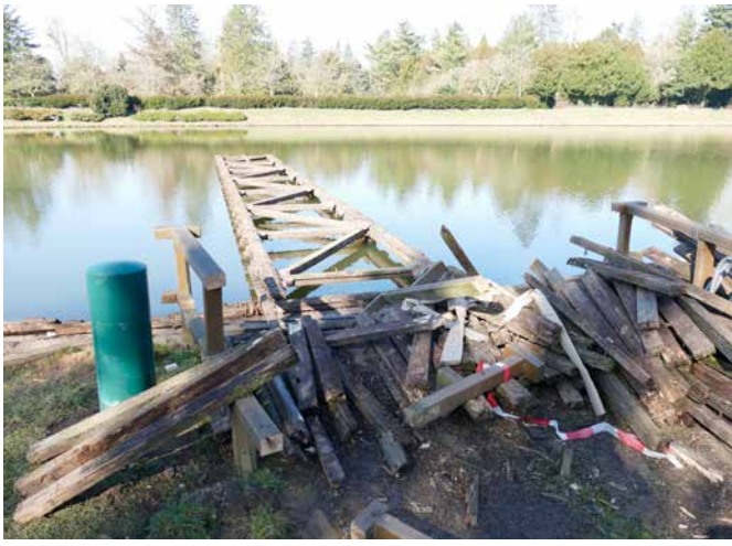
Abbruch der alten Steganlage
