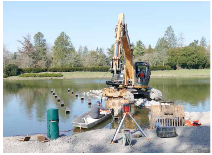
Setzen der Gründungspfähle für den neuen Seesteg
