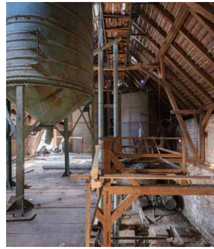
Tür der westlichen Scheune und ehemalige Getreide-trocknungsanlage
