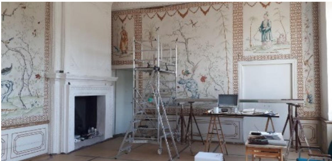
Restaurierungsarbeiten in einem der chinesischen Räume, © KsDW, Linda Kühnel
